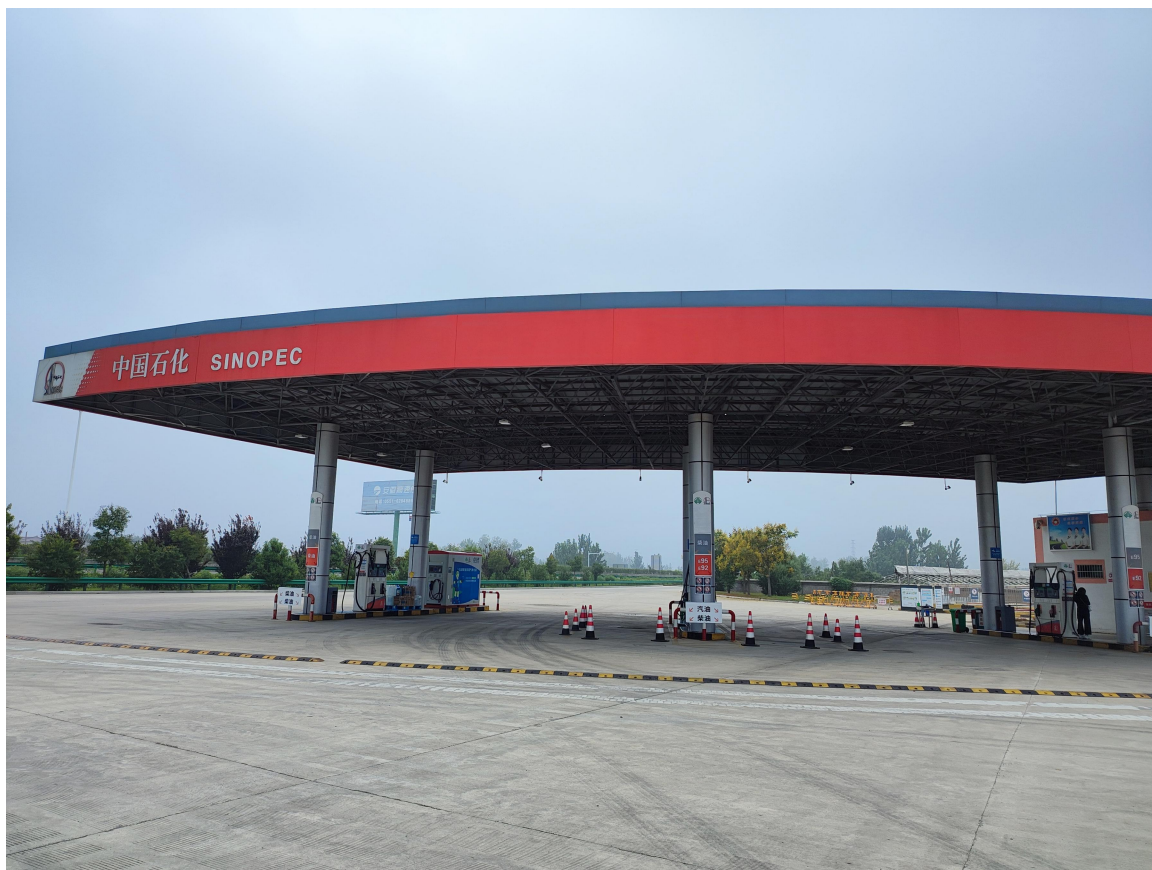
图 2-1 安徽省高速石化有限公司砀山服务区加油东站外观图
