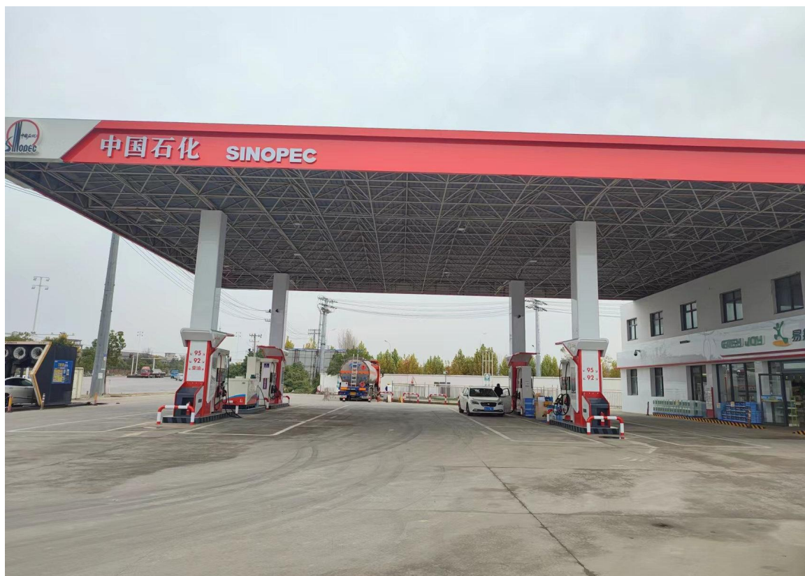
图 2-1 中国石化销售股份有限公司安徽淮南寿县新桥产业园区加油加气站外观图
