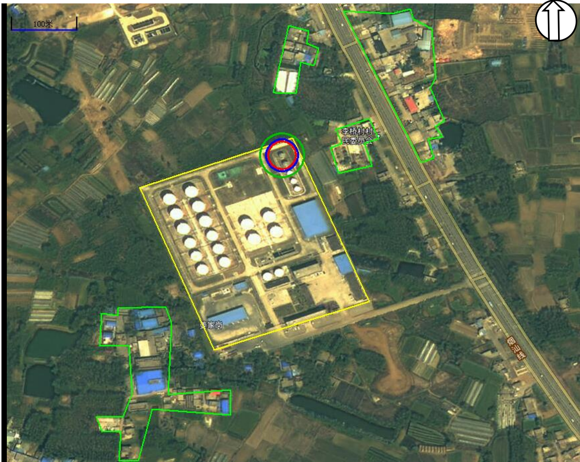
图 4. 2-3 T 2 罐区 2#乙醇储罐（管道大孔泄露）池火灾事故伤亡范围 事故后果分析结果：死亡半径21m，重伤半径24m，轻伤半径33m。
