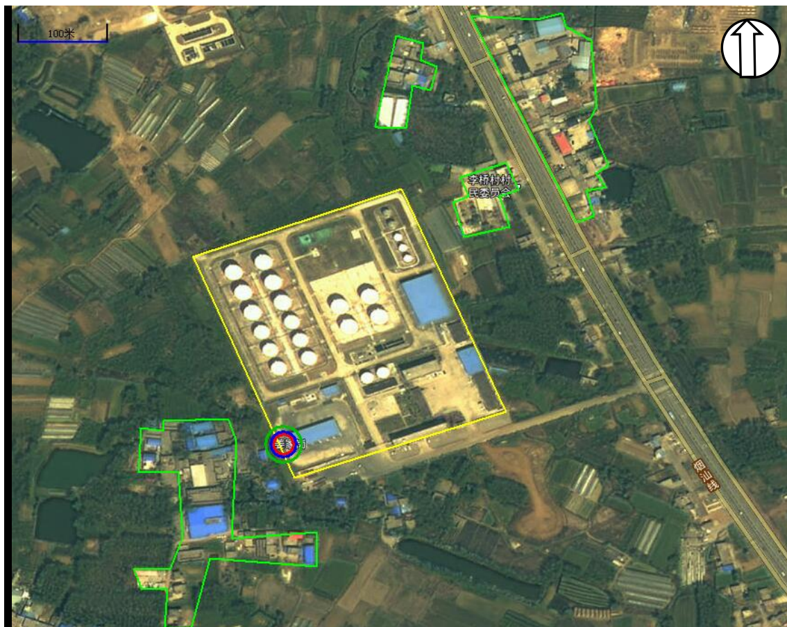
图 4.2-5 发油台（阀门中孔泄露）池火灾事故伤亡范围
