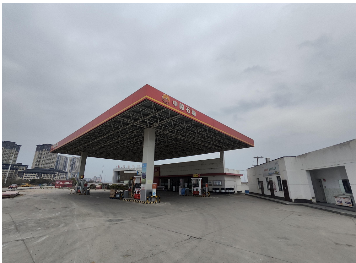
图 2-1 中国石化天然气股份有限公司安徽蚌埠销售分公司固镇城南加油站
