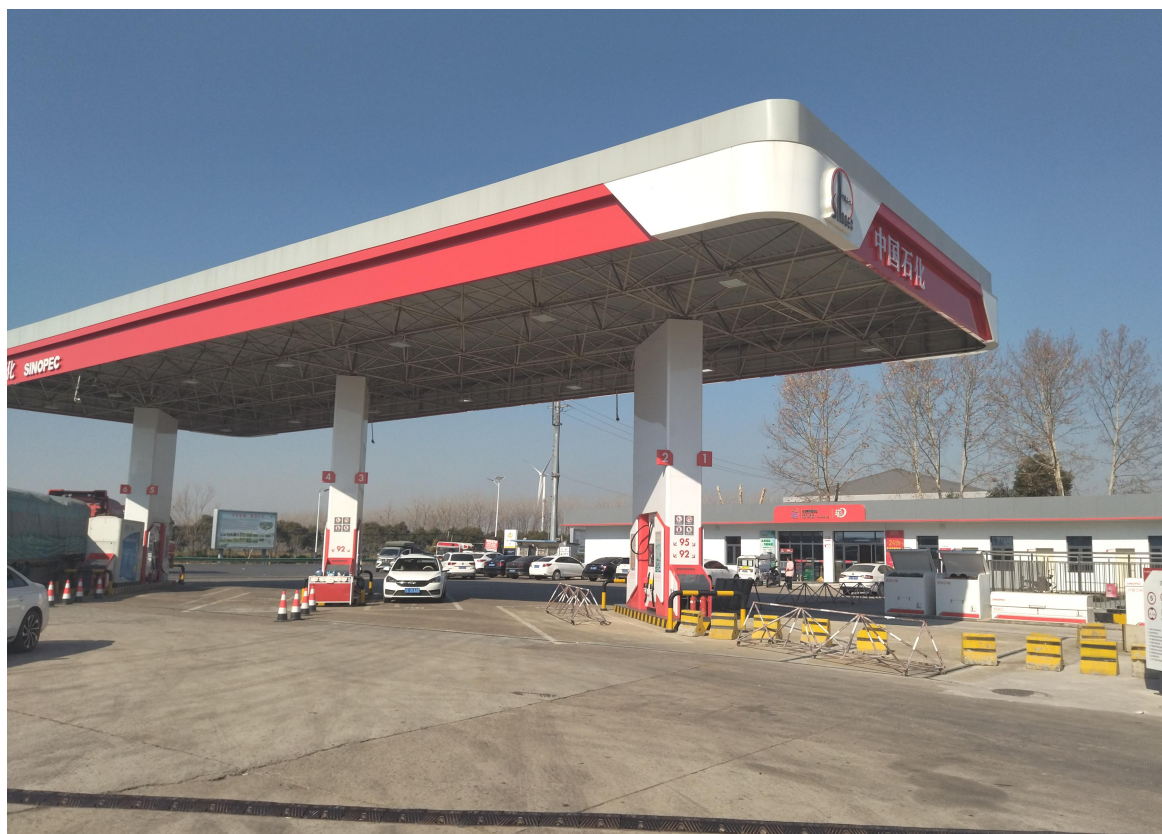
图 2-1 安徽省高速石化有限公司汝西营加油站 外观图
