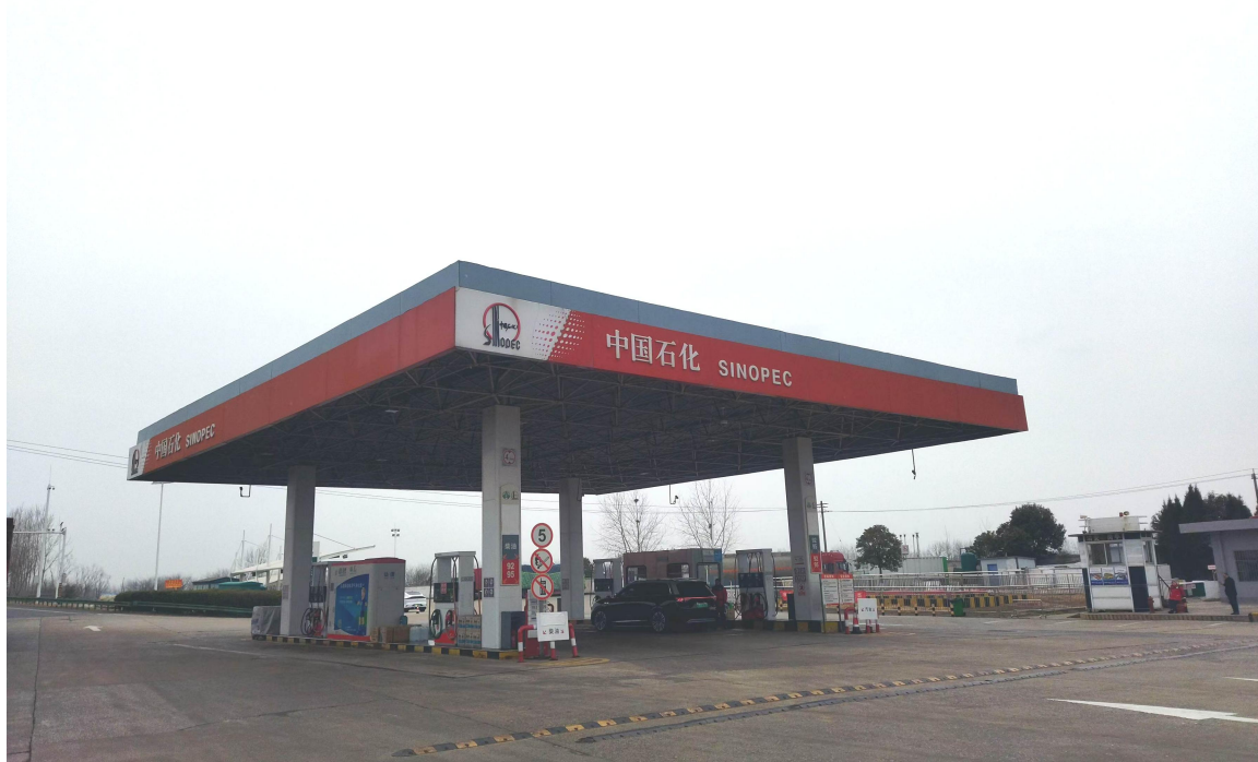
图 2-1 安徽省高速石化有限公司宿州符离加油西站 外观图
