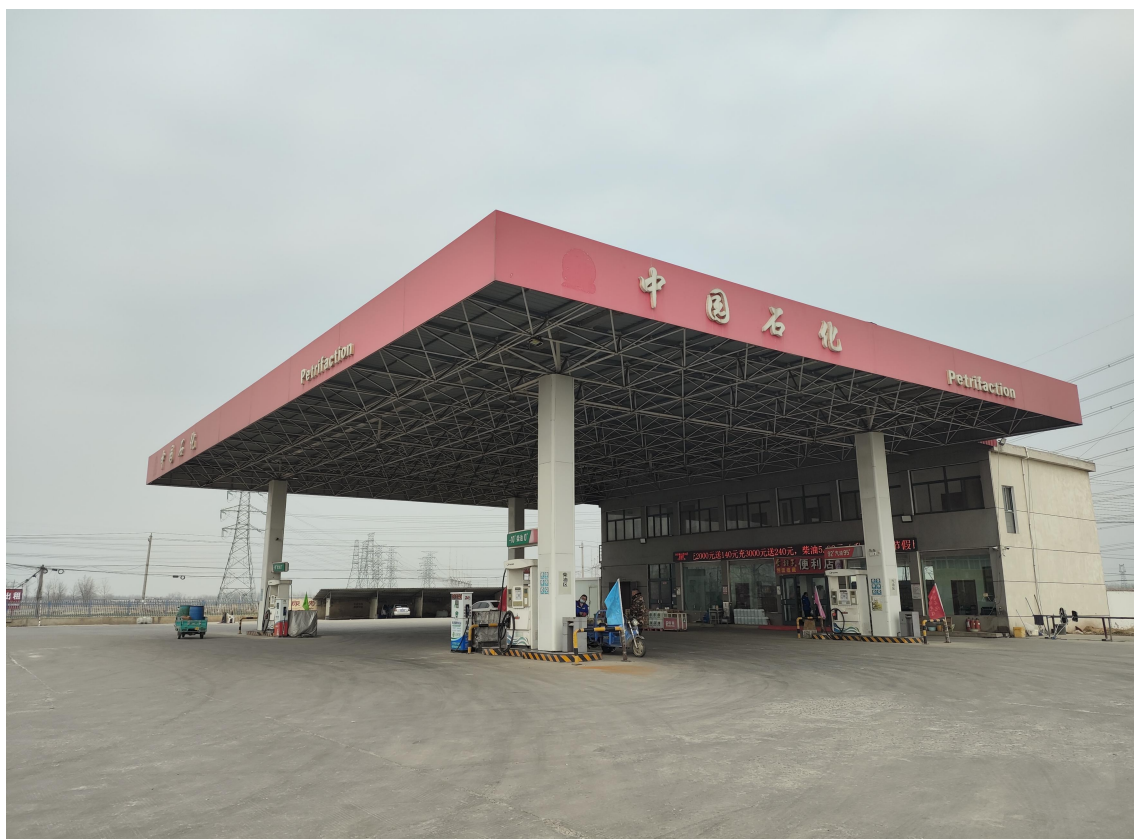
图 2-1 五河县中园石化销售有限公司园集加油站
