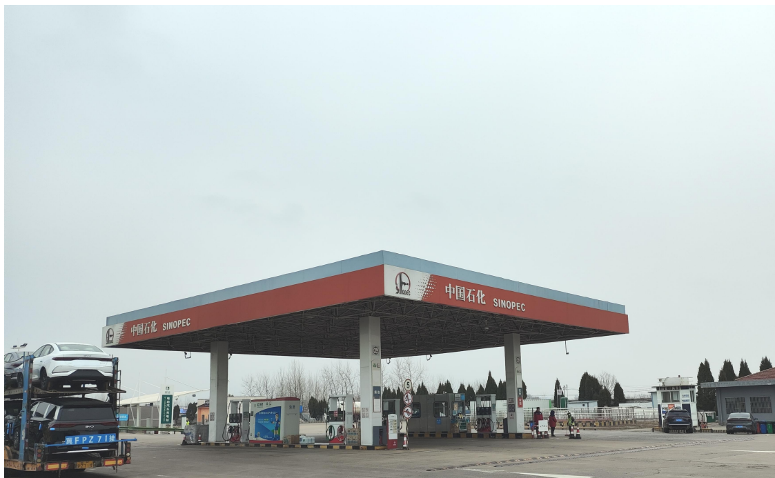
图 2-1 安徽省高速石化有限公司宿州符离加油东站 外观图
