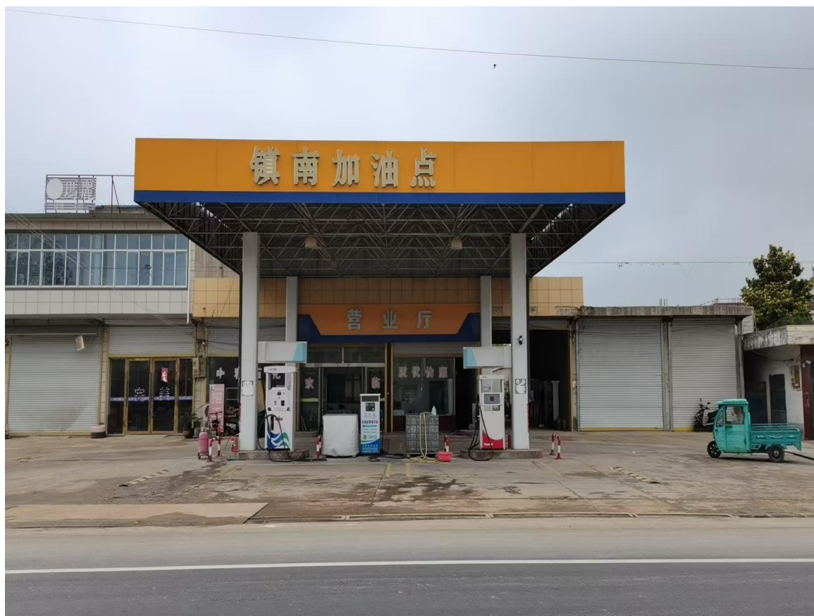
图2-1蒙城县板桥镇南加油点外观图
