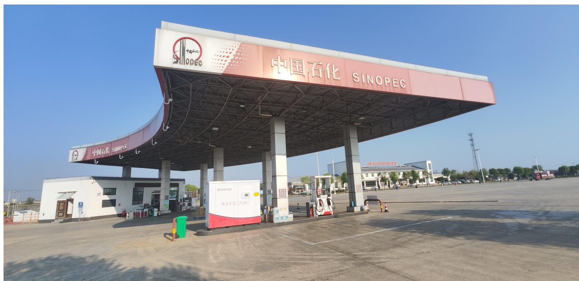
图 2-1 安徽省高速石化有限公司篱笆镇服务区加油站东站外观图
