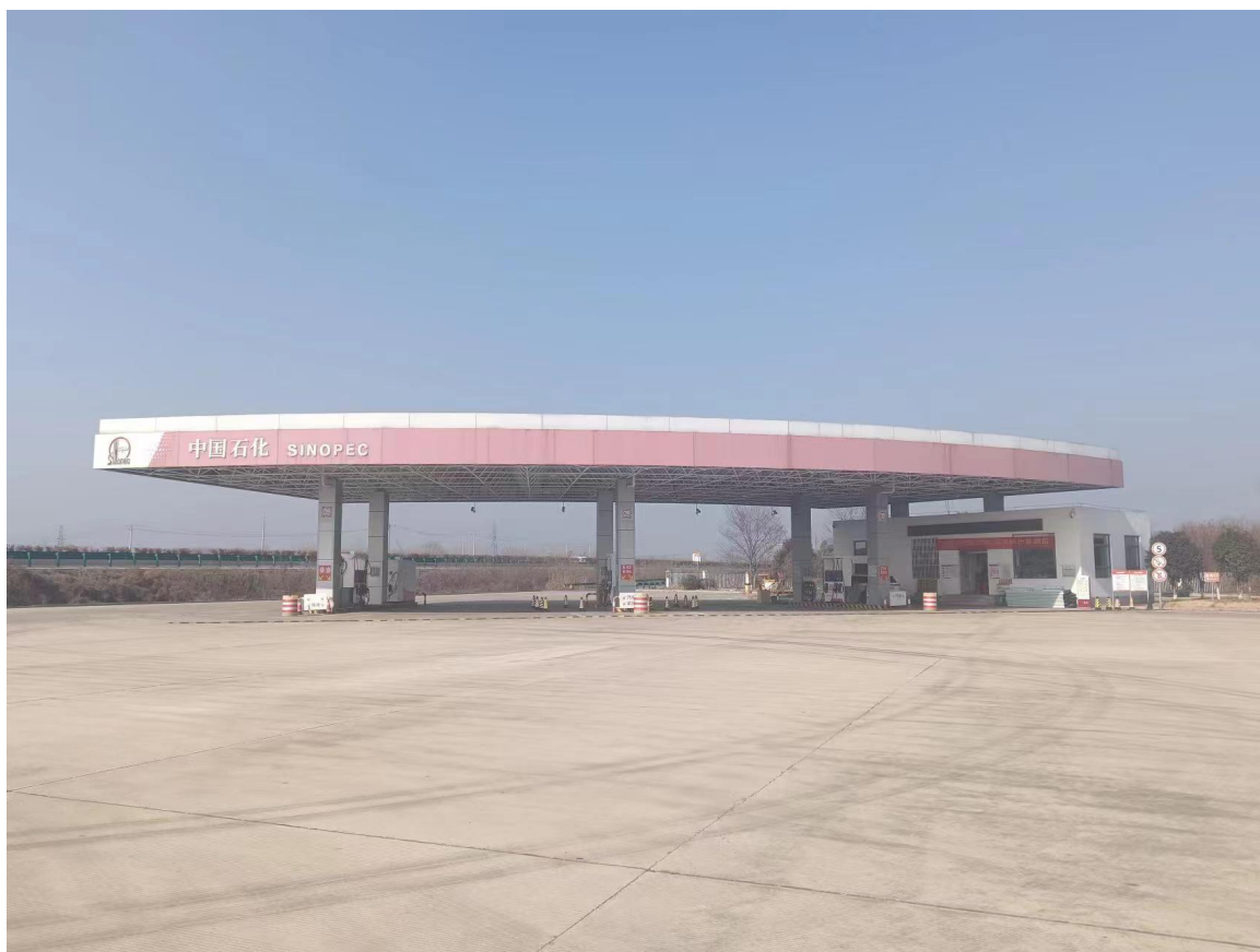
图 2-1 安徽省高速石化有限公司寿县茶庵服务区加油站东站外观图
