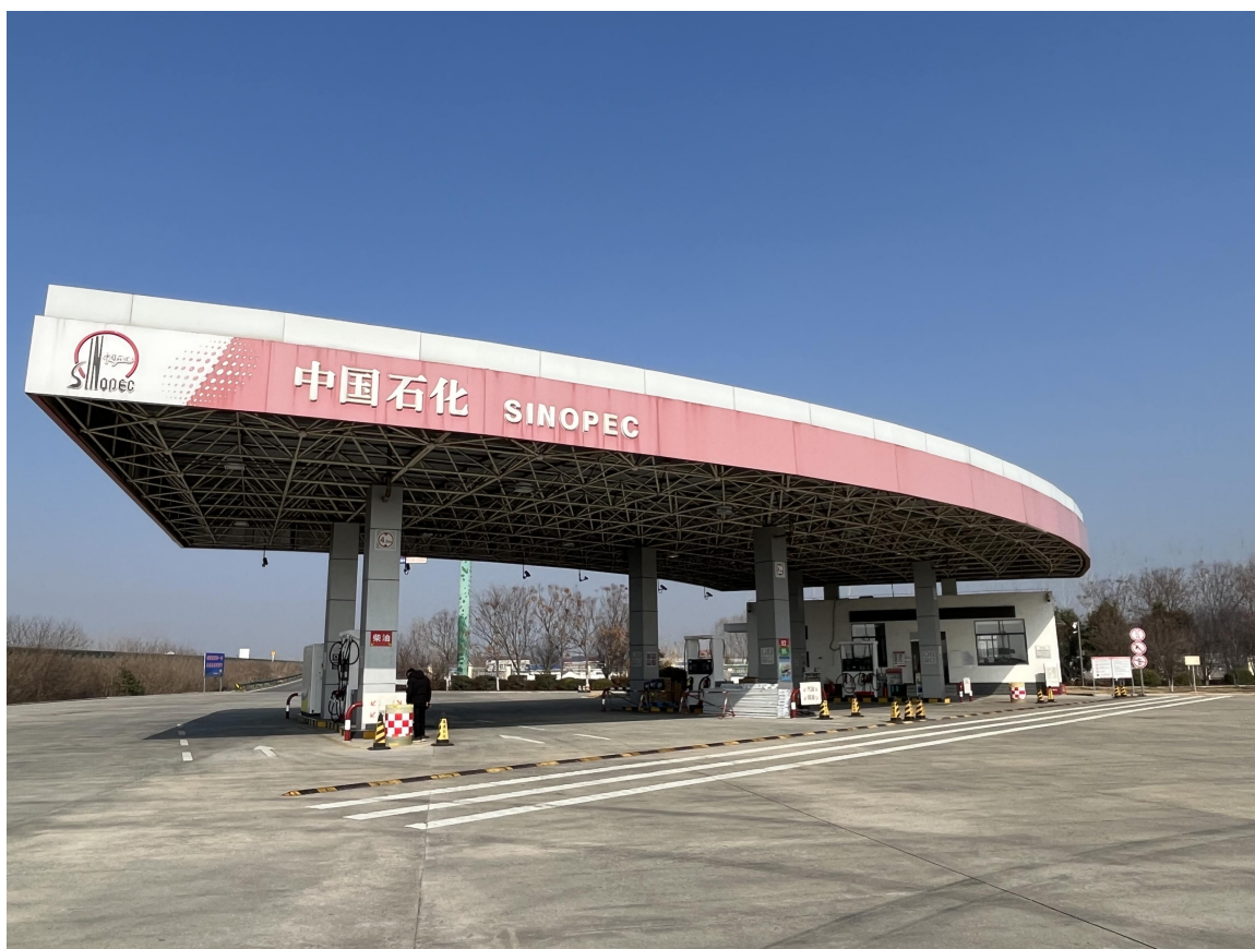
图 2-1 安徽省高速石化有限公司寿县堰口服务区加油站东外观图
