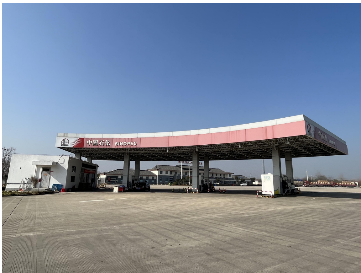
图 2-1 安徽省高速石化有限公司寿县茶庵服务区加油站西站外观图
