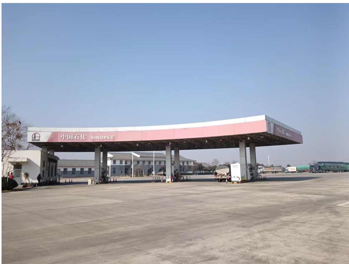
图 2-1 安徽省高速石化有限公司寿县堰口服务区加油站西站外观图
