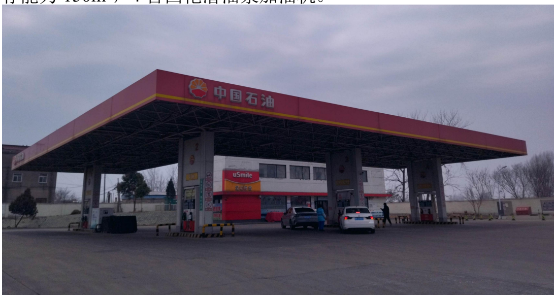
图 2-1 五河中油石油销售有限公司小溪加油站外观图
