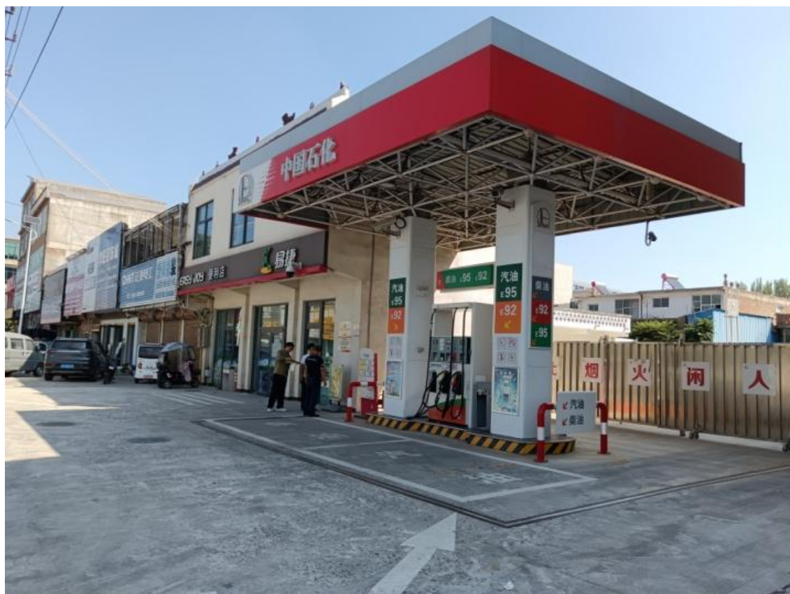
图 2-1 中国石化销售股份有限公司安徽亳州古城加油站
