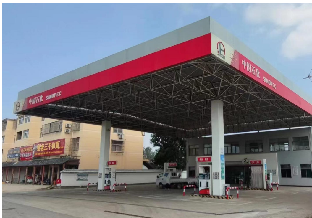
图 2-1 安徽亳州涡阳石油分公司义门加油站外观图
