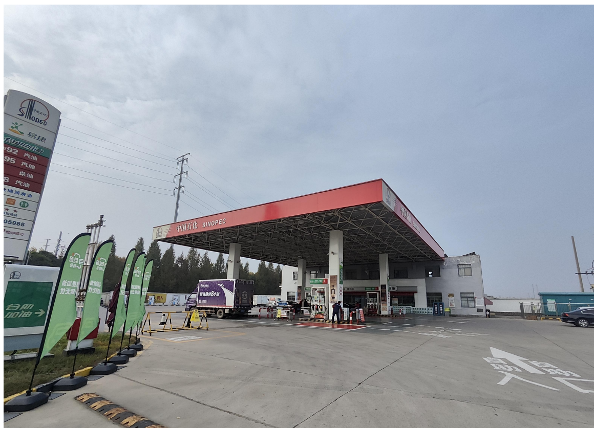
图 2-1 中国石化销售股份有限公司安徽亳州南外环加油站
