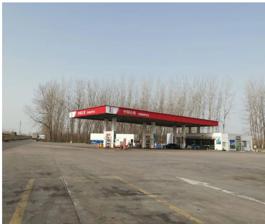
图 2-1 中国石化销售股份有限公司安徽亳州亳阜高速公路辛集服务区路东加油站
