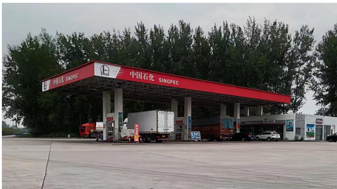
图 2-1 中国石化销售股份有限公司安徽亳州亳阜高速公路辛集服务区路东加油站
