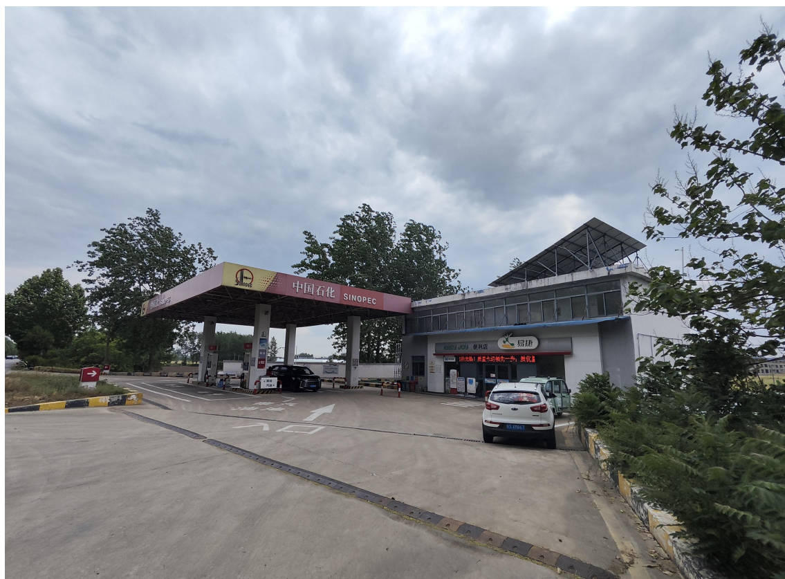
图 2-1 中国石化销售股份有限公司安徽亳州利辛石油分公司程集加油站
