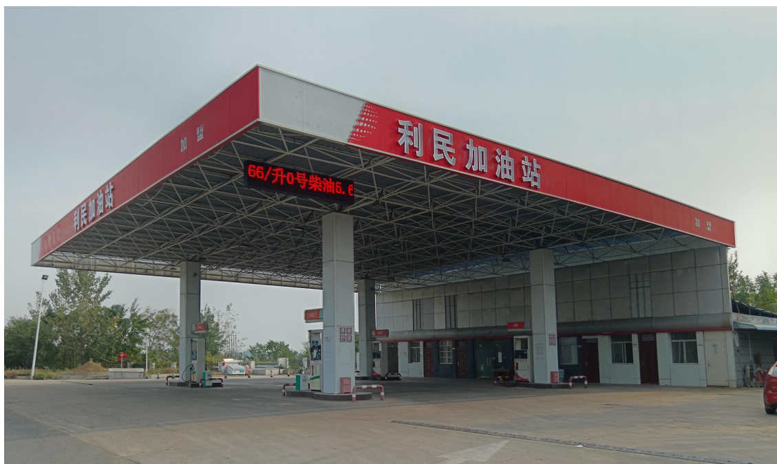
图 2-1 利辛县阚疃镇镇东利民加油站
