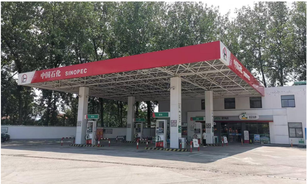
图 2-1 中国石化销售股份有限公司安徽亳州利辛石油分公司利望加油站
