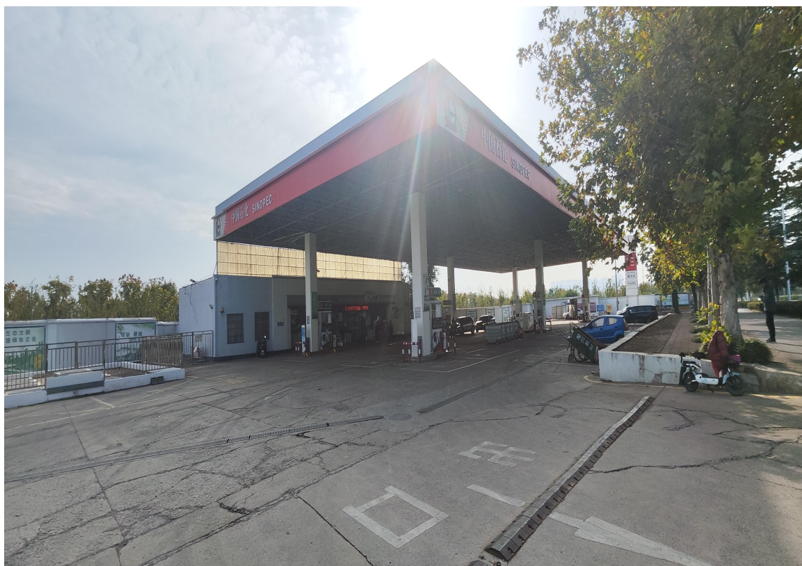
图 2-1 中国石化销售股份有限公司安徽淮南望峰岗加油站外观图
