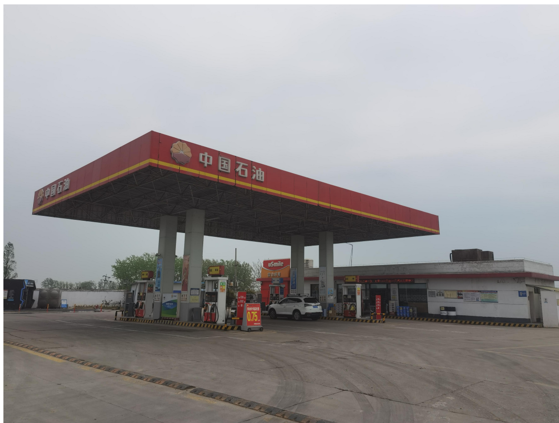
图 2-1 中国石油天然气股份有限公司安徽淮南销售分公司寿县国豪加油站外观图
