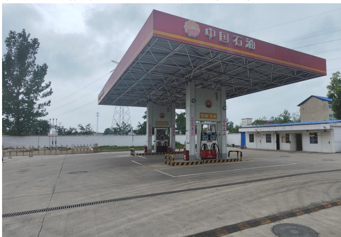
图 2-1 中国石油天然气股份有限公司安徽淮南销售分公司 凤台新集加油站外观图
