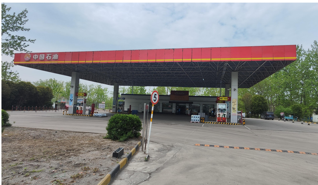
图 2-1 中国石化天然气股份有限公司安徽淮南销售分公司凤台铁路桥加油站
