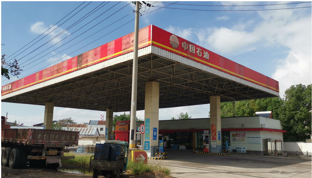
图 2-1 中国石油天然气股份有限公司安徽淮南销售分公司洛河加油站外观图
