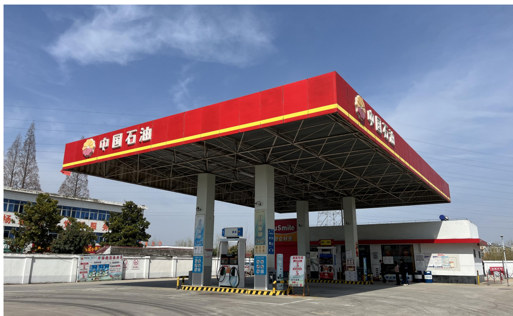
图 2-1 中国石油天然气股份有限公司安徽淮南销售分公司新路口加油站
