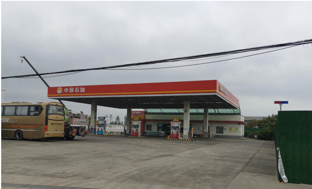
图 2-1 中国石油天然气股份有限公司安徽淮南销售分公司长江路加油站外观图
