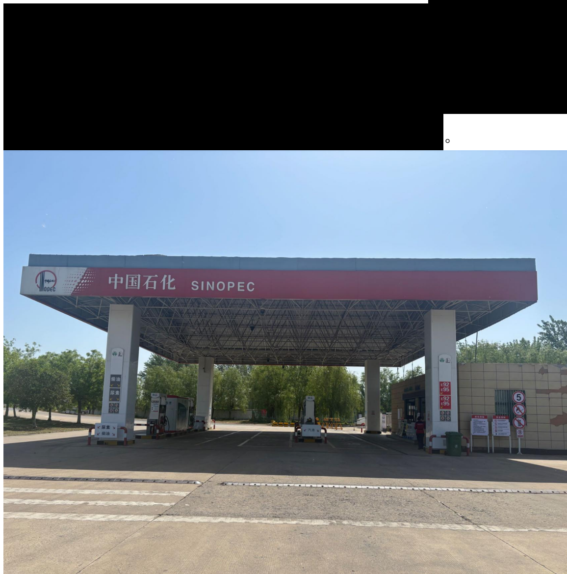
图 2-1 安徽省高速石化有限公司宿州王寨服务区加油南站
