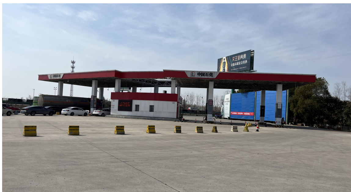
图 2-1 安徽省高速石化有限公司淮南八公山加油北站
