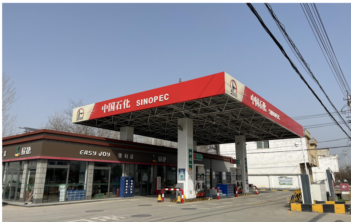
图 2-1 中国石化销售股份有限公司安徽亳州大寺加油站
