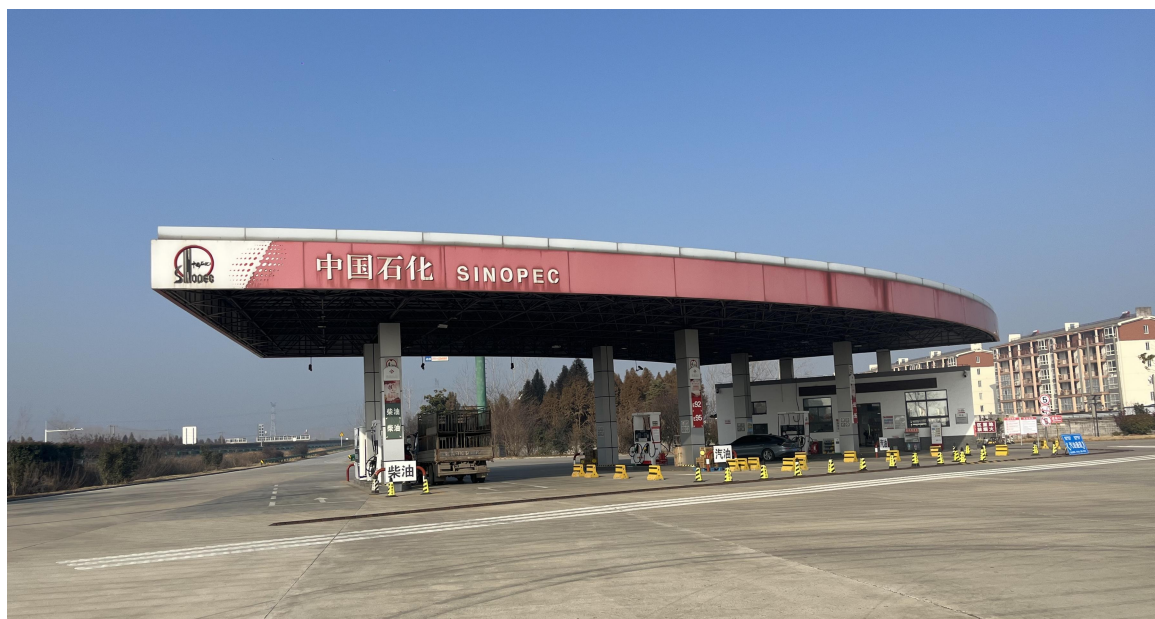
图 2-1 安徽省高速石化有限公司凤台服务区加油站东站
