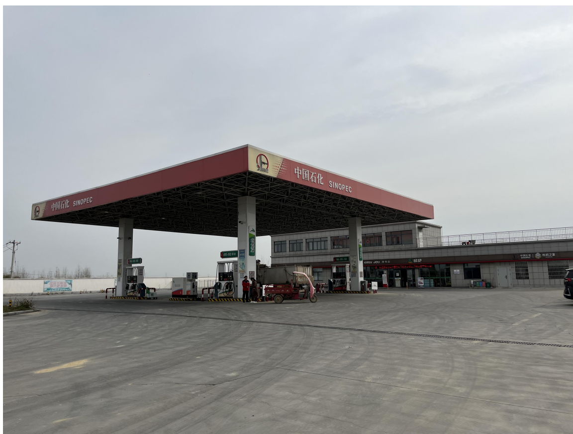
图 2-1 中国石化销售股份有限公司安徽淮南寿县刘岗望塘寺加油站
